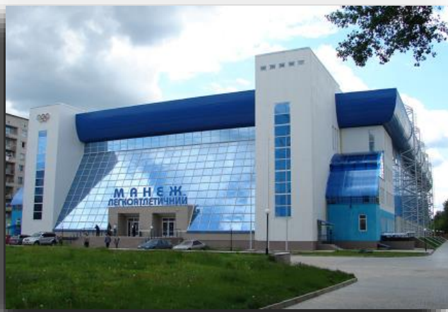
Будівництво універсального легкоатлетичного манежу
